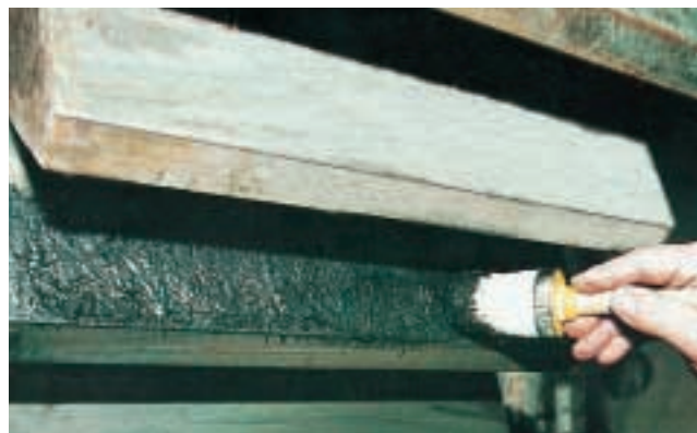
Der Schmierfilm muß gleichmäßig und ohne Lufteinschluß aufgetragen werden. The film of lubricant must be applied evenly and without bubbles.
