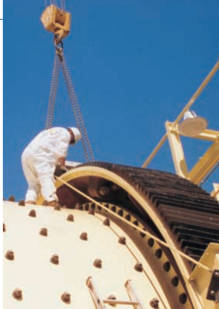
Inspektionen und Reparaturen vor Ort zählen zum Service von FUCHS LUBRITECH. Inspections and repairs on site are part of the FUCHS LUBRITECH service.
